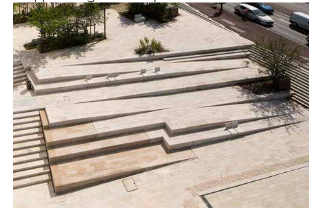
Trappeanlæg med rampe
