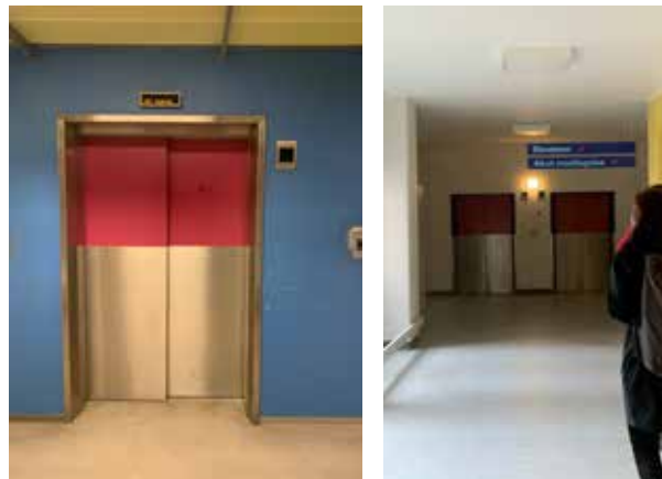
Eksisterende elevatorer forbinder på tværs
