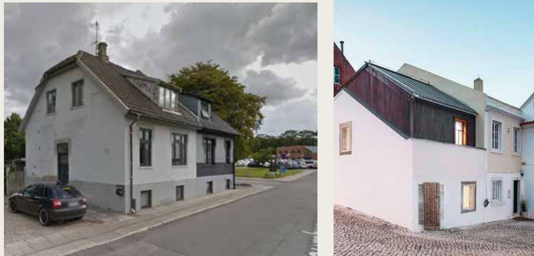
Det eksisterende dobbelthus kan renoveres evt. med en ny tagetage. Her kan indrettes værksted og vaskeri i kælderen og fælleskøkken i den ene halvdel i stueetagen. Resten kan fungere som clusterboliger.
