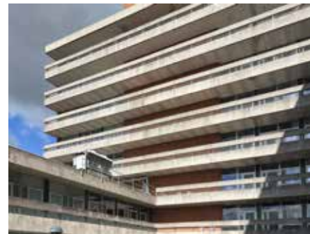
Byg. 23 - Blid brutalisme
