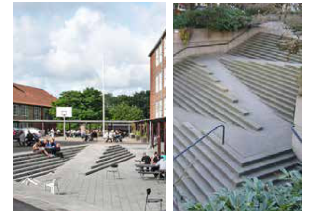
Trappeanlæg med rampe
